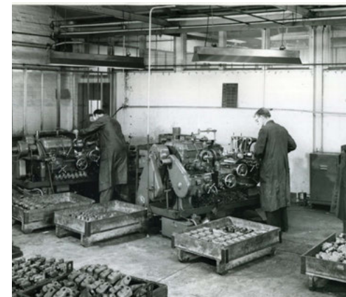
Usinage des purgeurs de vapeur à l'usine britannique de Velan.
